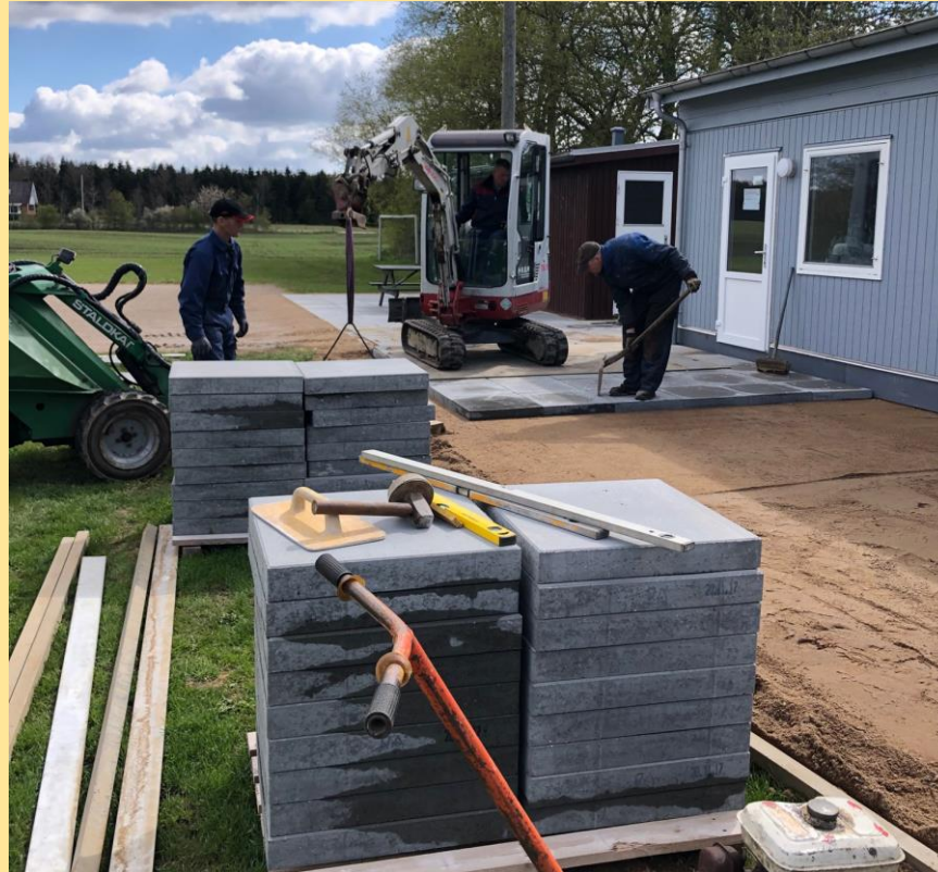
Lægning af fliser
